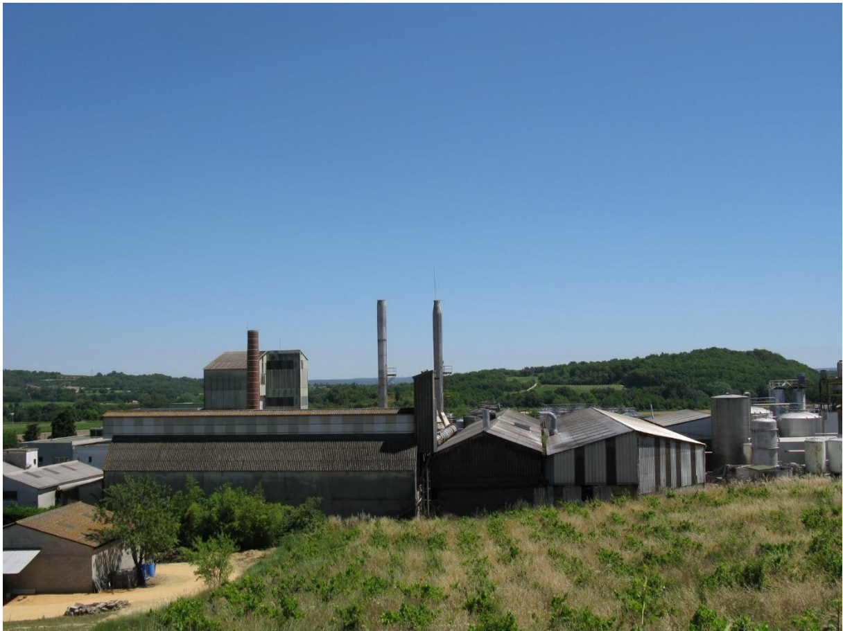
Vue depuis la dent creuse « archéologique » de Cruviers sur la distillerie.
